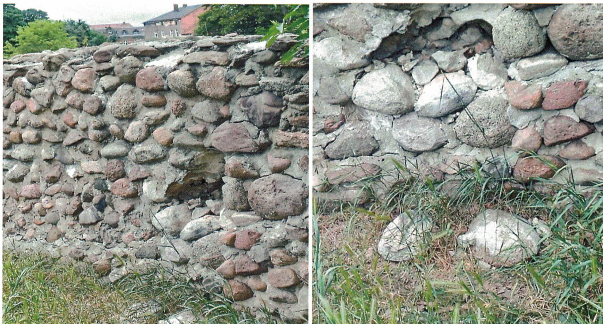
Mur obronny przy ulicy Sobieskiego
